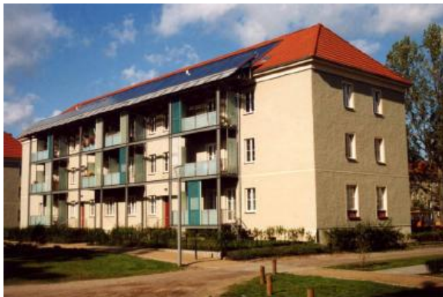
Foto 1: Solaranlage Cohnsches Viertel (Quelle: Stadt Hennigsdorf)
