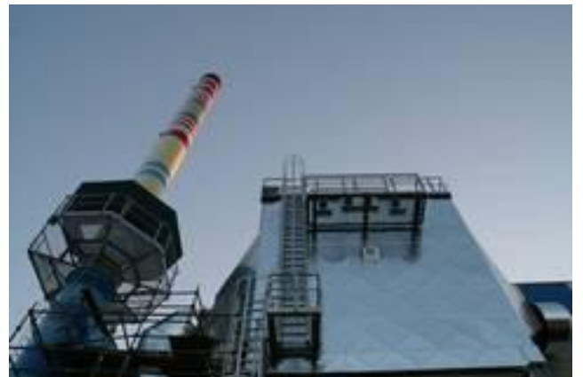
Foto 2. 1: Biomasseheizkraftwerk (Quelle: KPG)
