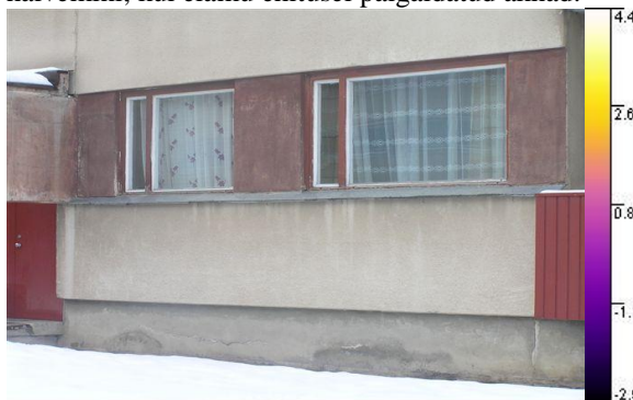
Soojustamata, niiskunud vundament ja kõrge temperatuur keldriruumides põhjustavad vundamendi pinnalt suured soojuskaod. (Hele toon vundamendil viitab suhteliselt kõrgele pinna temperatuurile)
