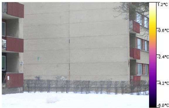
Seinas oleva vuugi prao kaudu liigub külm õhk seinakonstruktsiooni sisse.
