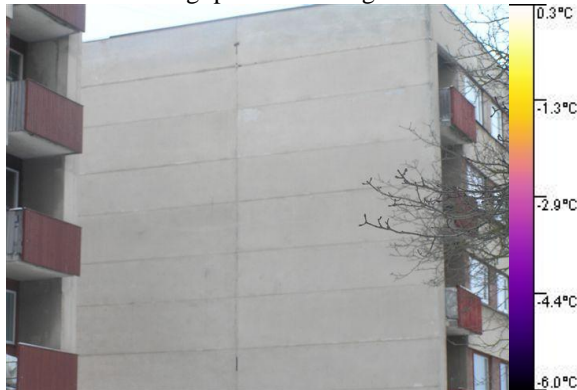
Rõdu seinad ja katuse äär moodustavad külmasilla osaliselt ülemise korruse korteri sein.
