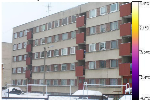
Akende vaheseinad juhivad soojust paremini, kui ülejäänud sein. Pakettaknad juhivad soojust halvemini, kui elamu ehitusel paigaldatud aknad.
