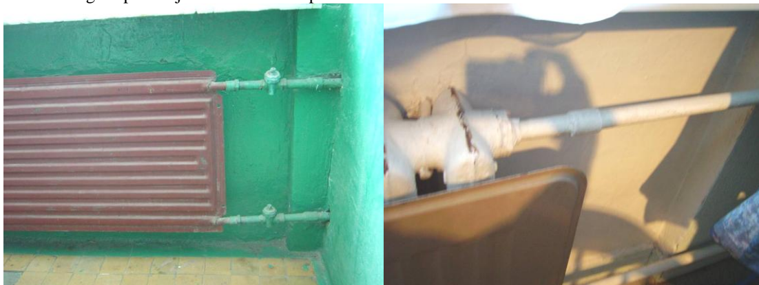
Elamus on ülaltjaotusega ühetorusüsteem, radiaatori tasandil reguleerimatu.
