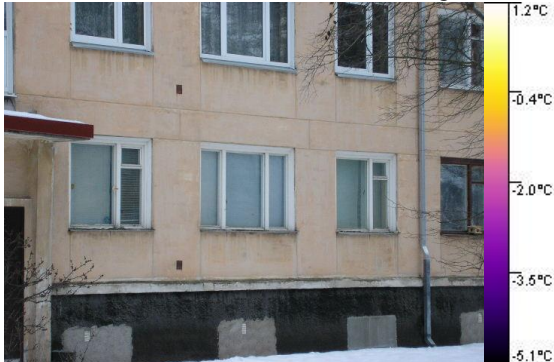
Seinte soojusjuhtivustegur on ehituse aegsel tasemel ja radiaatorite soojust on "tunda" ka välisseina pinnal.
