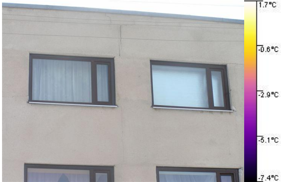
Paneelide ühenduskohad juhivad soojust paremini, sest tsementmört on parem soojusjuht.
