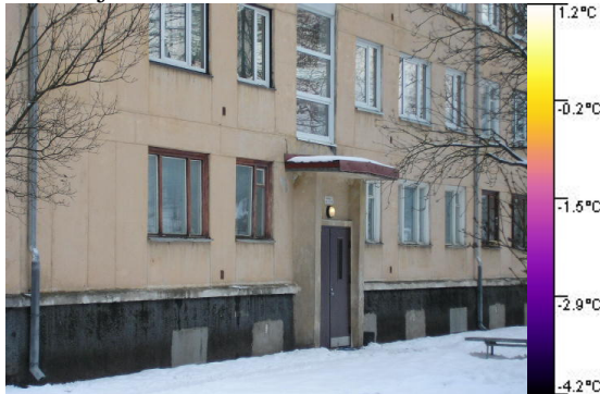
Vundament tuleks kindlasti niiskustõkkega varustada ja soojustada juhul, kui seintele lisasoojustus paigaldatakse.
