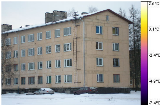
Tuletõrje redeli ülaosas on katusest niiskus tunginud seinakonstruktsiooni.
