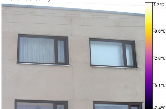
Paneelide ühenduskohad juhivad soojust paremini, sest tsementmört on parem soojusjuht.
