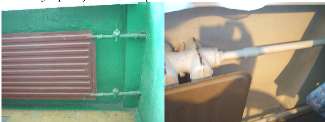
Elamus on ülaltjaotusega ühetorusüsteem, radiaatori tasandil reguleerimatu.
