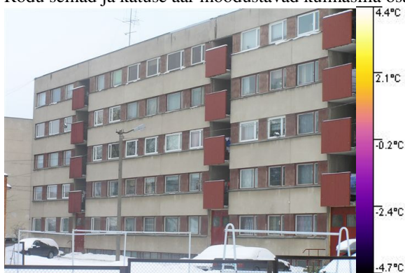
Akende vaheseinad juhivad soojust paremini, kui ülejäanud sein. Pakettaknad juhivad soojust halvemini, kui elamu ehitusel paigaldatud aknad.
