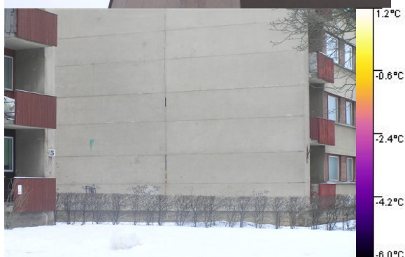
Seinas oleva vuugi praod kaudu liigub külm õhk seinakonstruktsiooni sisse.
