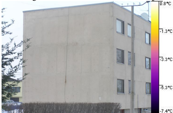
Külmasillad paneelide ühenduskohtades, vasakpoolne otsakorter võib olla alaköetud või piisavalt ventileerimata (seest niiskunud sein)
