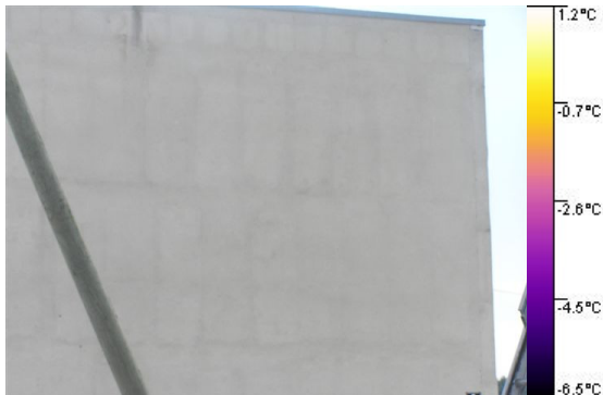
Sissetunginud niiskusest tekib külmasild ja korteri sein võib hakata seestpoolt kondensaati koguma.
