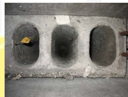
14.att., tīri ventilācijas kanāli (464.sērijas daudzdzīvokļu ēka). [7]
