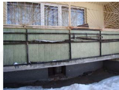
12.att., 12-stāvu daudzdzīvokļu ēkas lodžija Juglā [2]
