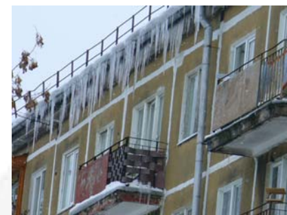
13.att., intensīvi siltuma zudumi (daudzdzīvokļu ēka Juglā). [2]
